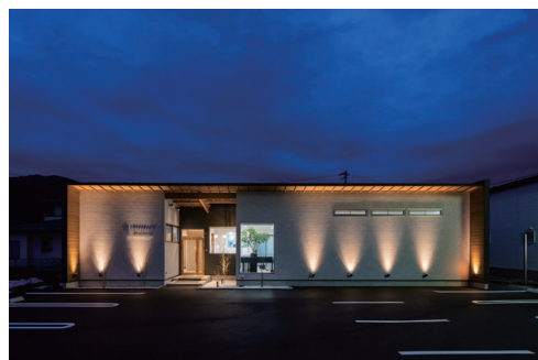
山崎泰史税理士事務所 新築工事
