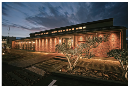
常磐城ガーデンレストラン 新築工事
