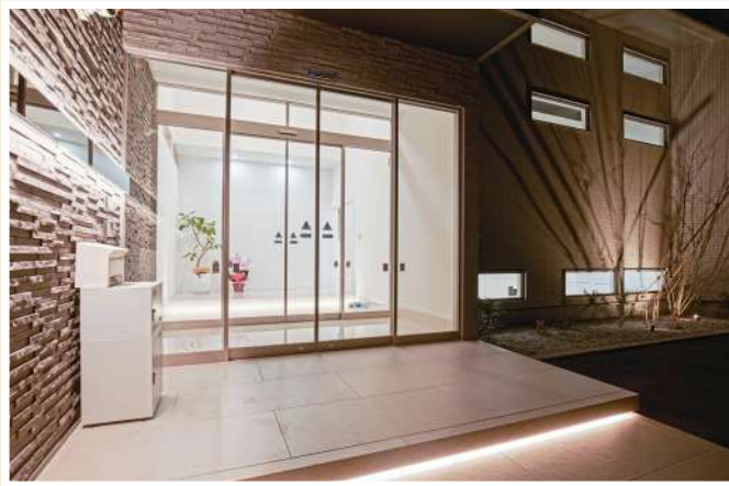
No.19 改装工事
