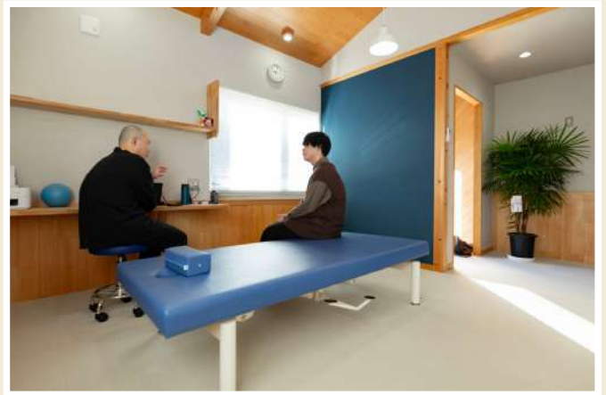
No.18 新装工事
