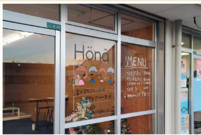
No.21 サイン工事
