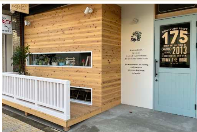
No.07 改装工事
