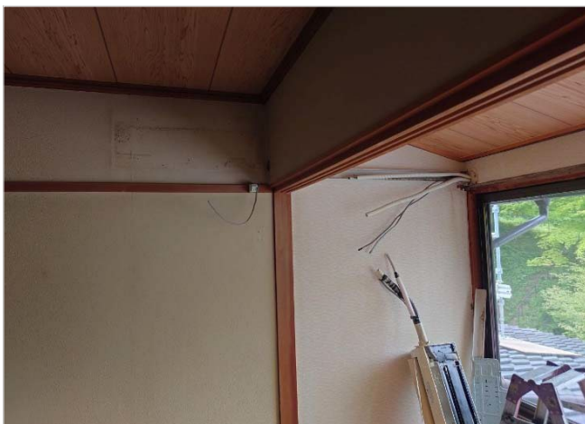
[工事種別] 空調工事 [作業内容] 客室エアコン取外し状況
