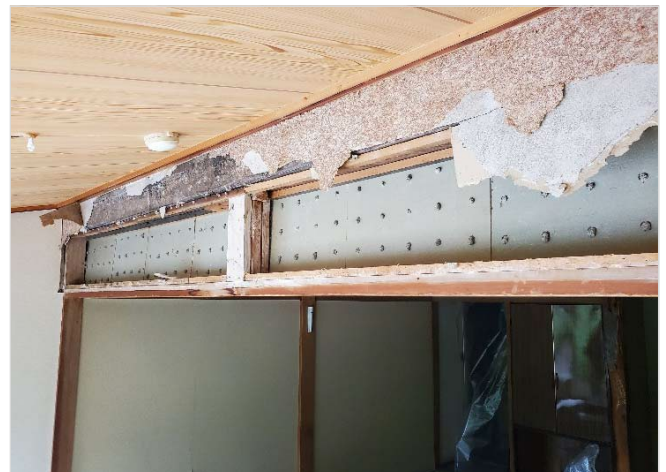
[工事種別] 解体工事 [作業内容] 客室H 垂れ壁解体状況
