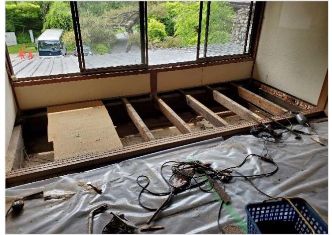
[工事種別] 解体工事 [作業内容] 客室U 床解体状況
