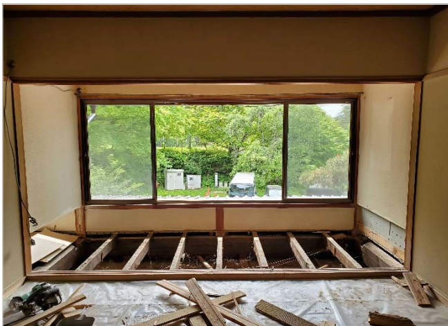
[工事種別] 解体工事 [作業内容] 客室K 床解体状況
