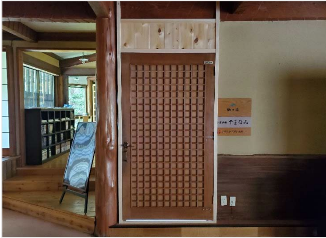
[工事種別] 仮設工事 [作業内容] 階段上り口仮設ドア取付け状況
