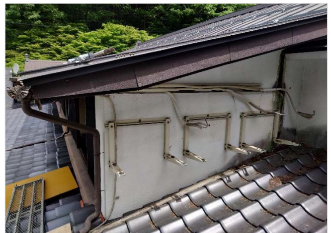
[工事種別] 空調工事 [作業内容] エアコン屋外機取外し状況
